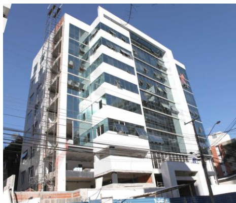
Prédio situado na rua da Glória, 290, que será inaugurado ainda este ano e abrigará oito das dez Varas de Família (da 1ª à 8ª) do Foro Central de Curitiba.
