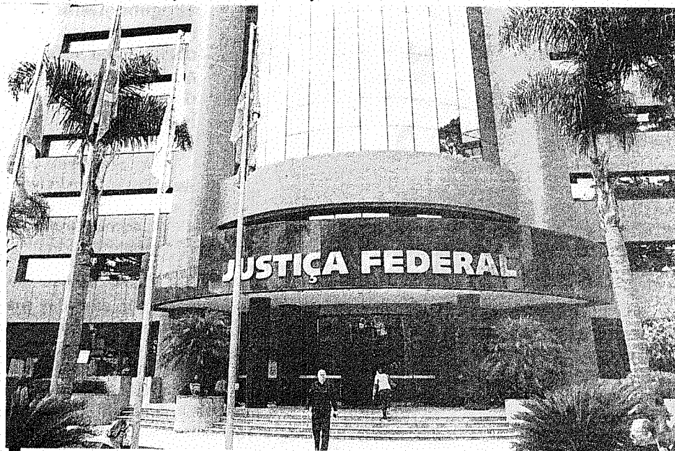
Prédio da Justiça Federal, na Ahú: cenário de embate da Lava Jato em Curitiba
