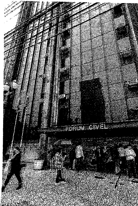
Prédio não corre risco de cair.
