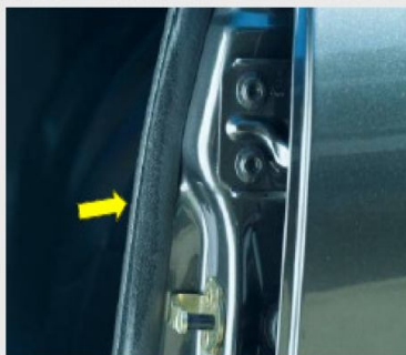
Desgaste natural das borrachas, tapetes, bancos, consoles e guarnições.
