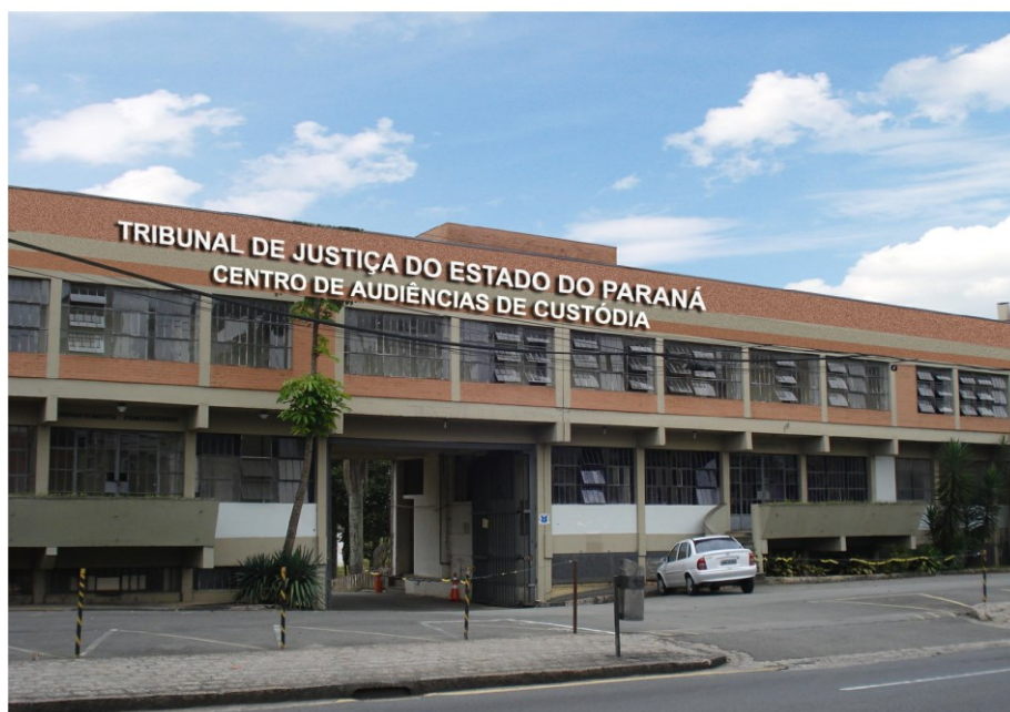
Vista fachada frontal
