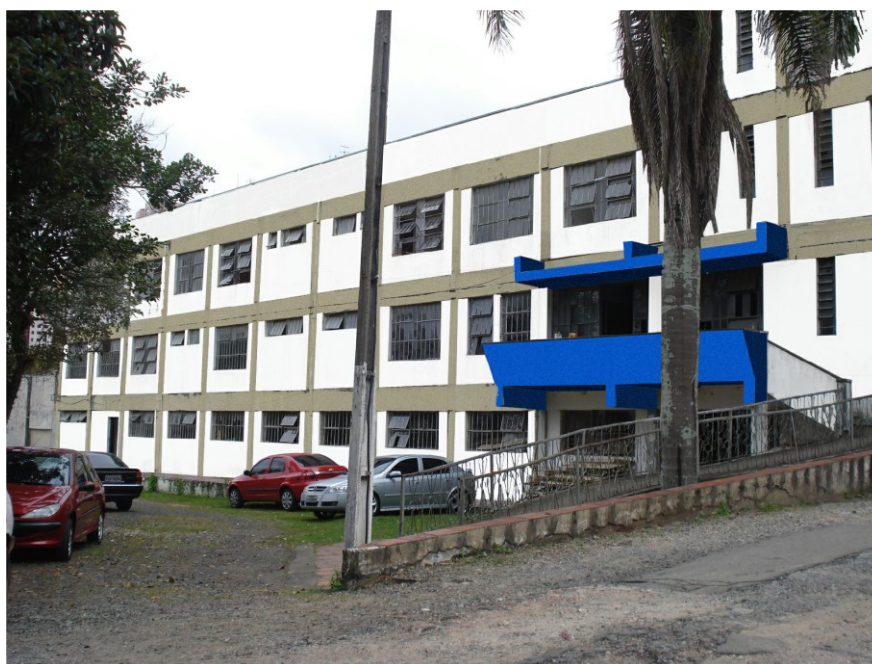
Vista fachada posterior
