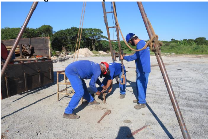
Figura 3 - Execução do furo SPT7
