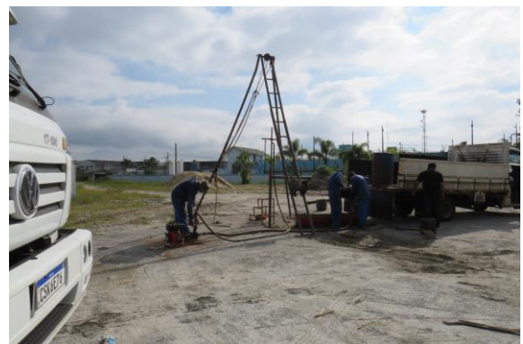
Figura 6 – Execução do furo SPT4
