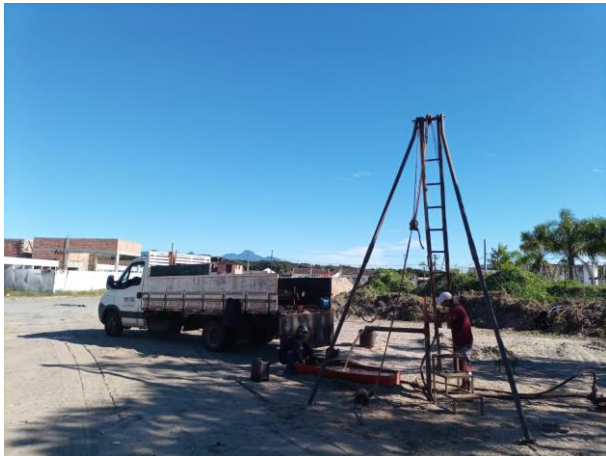
Figura 1 – Execução do furo SPT3
