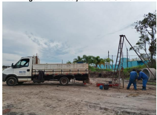
Figura 4 - Execução do furo SPT1
