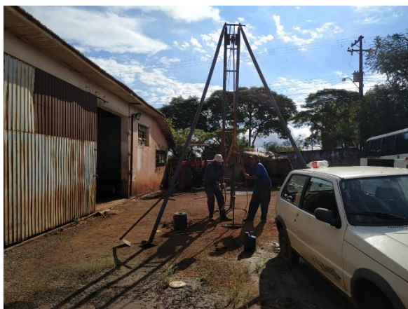
Figura 1 – Execução do furo 1
