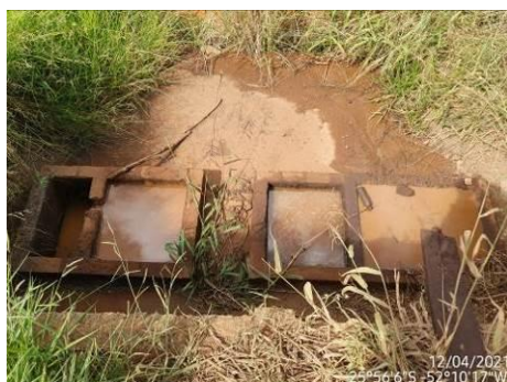
Foto 37: Vista interna do terreno, caixa separadora de óleo.
